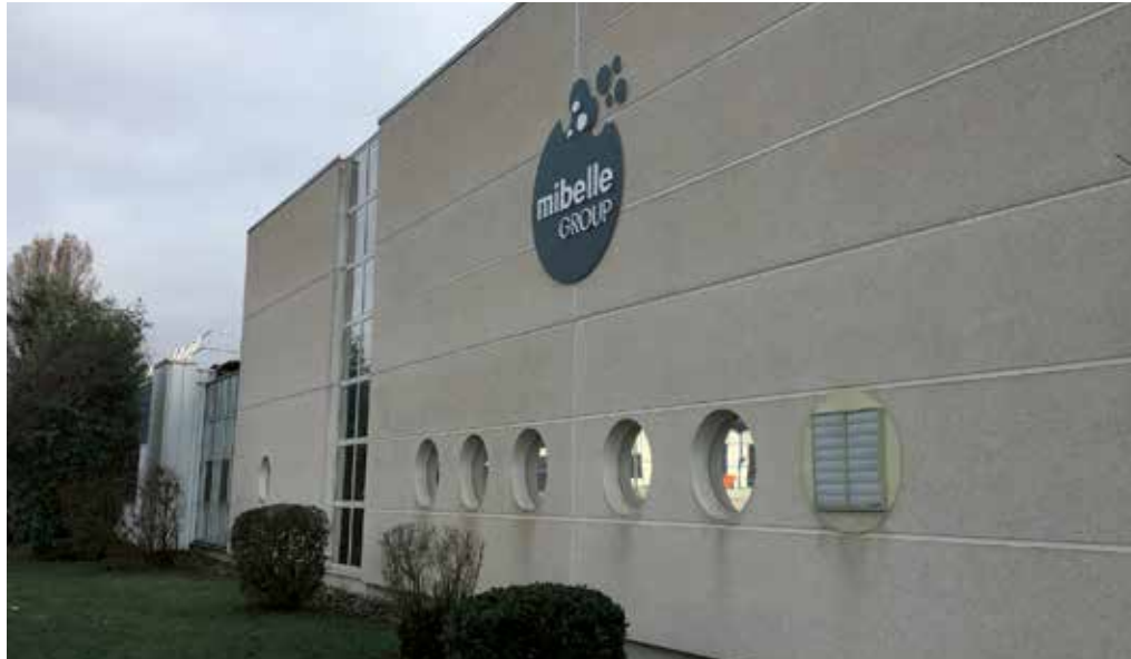
Nouvelle usine de Mibelle Group
