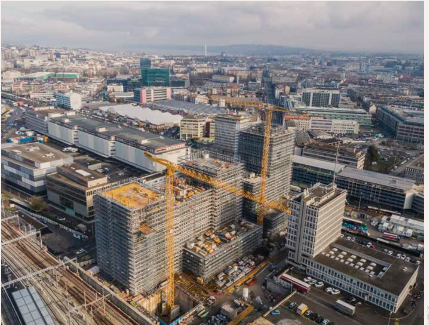
Pont-Rouge, le centre de Genève se déplace
