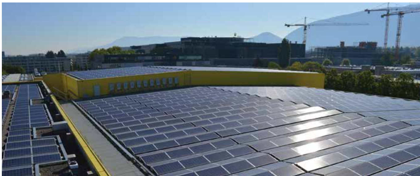
La dernière réalisation de PrimeEnergy est installée sur le toit des Laiteries Réunies de Genève.
